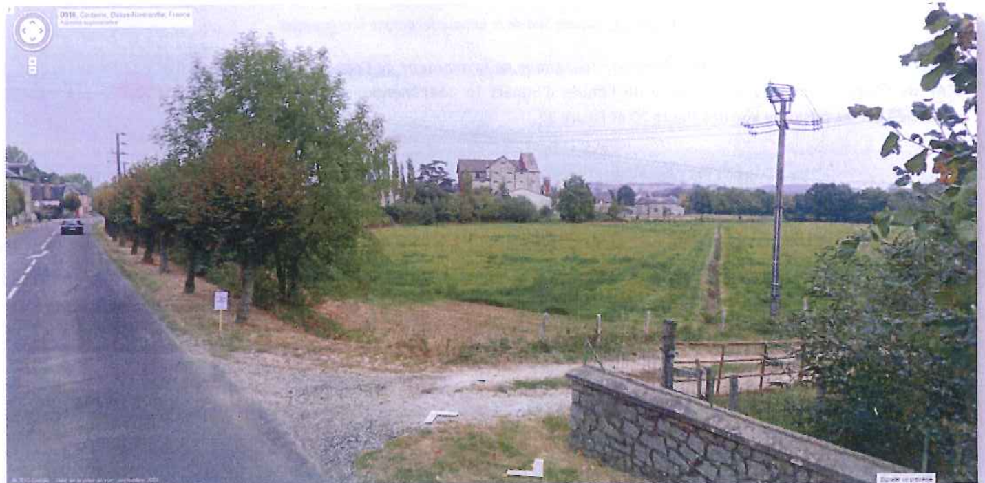
Figure 22 : Situation Sud de la minoterie (« Pont de Couterne »)
